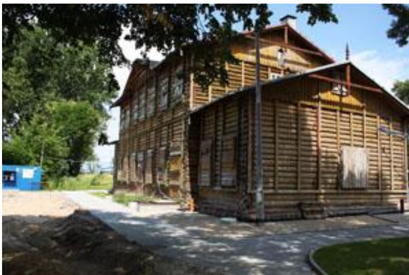
23. Zabytkowa stacja kolejowa Gąsocin po renowacji
