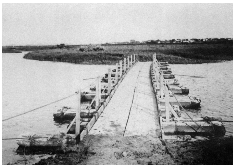
43. Tymczasowa saperska przeprawa wodna
