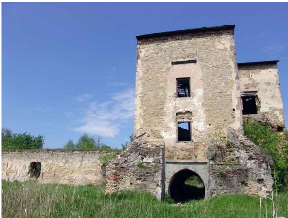
6. Obecny wygląd wieży bramnej i resztek murów - 2006 r.
