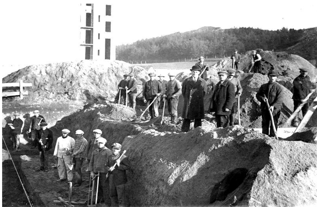
36. Kopanie fundamentów pod kamienicę w Gdyni w r. 1930
